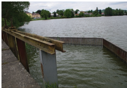
Obrázek 36: Česlová stěna před bezpečnostním přelivem.
