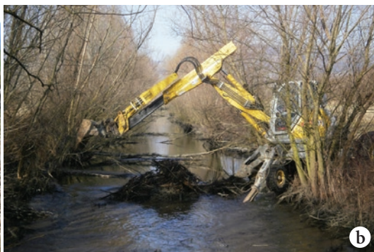
Obrázek 23: Částečné ubourání bobří hráze, tzv. otevření hráze (a); odstraňování hráze technikou (b).
