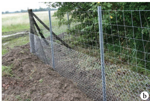
Obrázek 6: Oplocení porostu pletivem zapuštěným do země a ohnutým do tvaru písmene L ve fázi před zahrnutím vodorovné části zeminou (a); zesílení stávajícího oplocení přidáním pletiva, které musí být rovněž zapuštěno do země nebo při zemi ohnuto do tvaru L (b).
