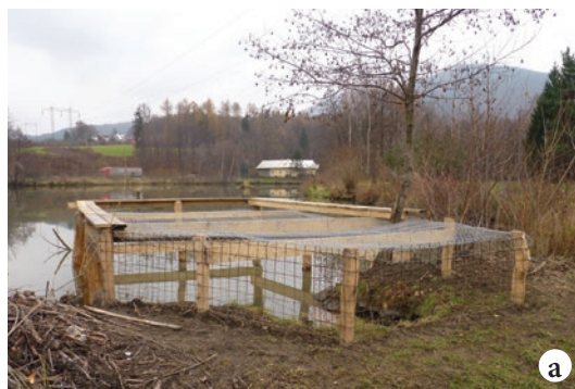
Obrázek 35: Bobří zábrana v Rožnově pod Radhoštěm při stavbě v roce 2012 (a) a po třech letech fungování (b).
