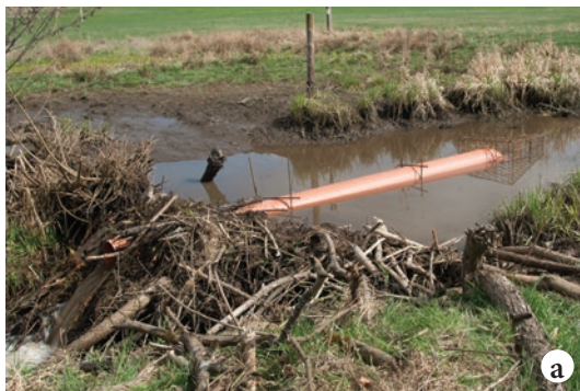
Obrázek 18: Drénování bobří hráze: trouba vložena do hráze s kolenem na nátoku a ochranným košem (a); detail nátoky trouby a ochranného koše (b).
