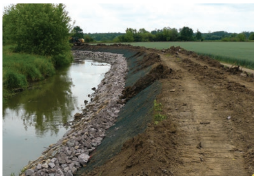
Obrázek 30: Pokládka pletiva do tělesa protipovodňové hráze na Kyjovce – svahy jsou chráněny pletivem proti prohrabání, spodní část koryta kamennou rovnaninou proti erozi břehu.
