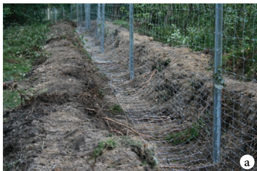
Obrázek 6: Oplocení porostu pletivem zapuštěným do země a ohnutým do tvaru písmene L ve fázi před zahrnutím vodorovné části zeminou (a); zesílení stávajícího oplocení přidáním pletiva, které musí být rovněž zapuštěno do země nebo při zemi ohnuto do tvaru L (b).
