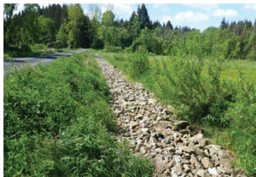
Obrázek 21: Cestní příkop zasypaný hrubozrnným materiálem. Dříve zde byla občasná vodoteč, kde bobra stavěl hráz, vzdouval vodu a ohrožoval tak cestní těleso.
